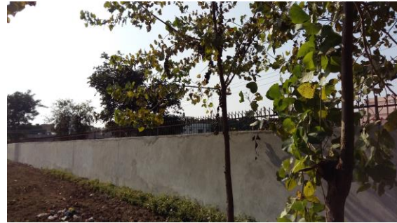
Neue Grenzmauer, Oktober 2016
