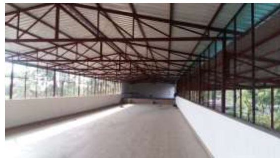
Dacharbeiten am Hauptgebäude (Mai 2017)
