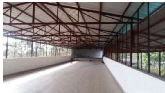
Dacharbeiten am Hauptgebäude (Mai 2017)
