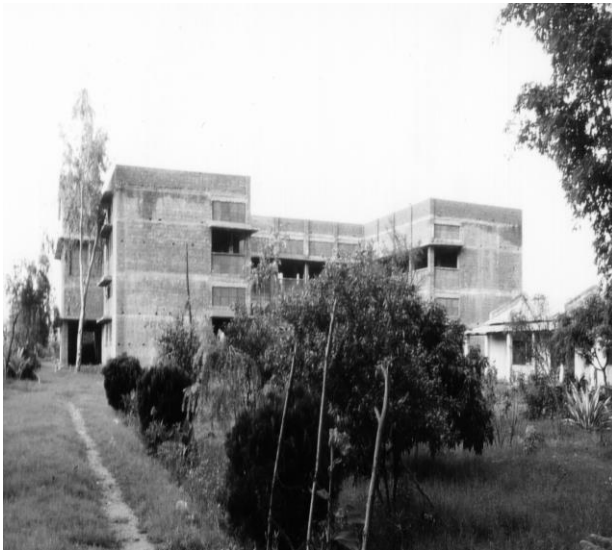
Das ursprünglich als Kindergarten und Erwachsenenbildungszentrum geplante Gebäude ist bereits im Rohbau fertig. Es fehlen nur noch die Innenarbeiten.
