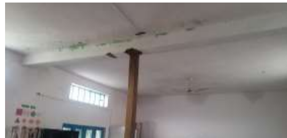
Behelfsmäßige Dachstütze im Labor (August 2021)
