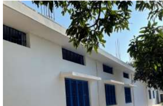
Laborgebäude in Jogiwala
